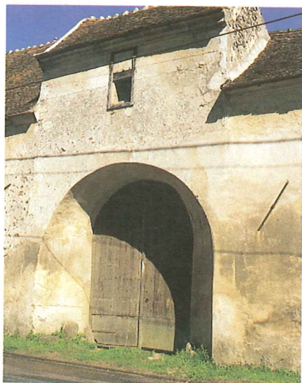
Porche d'un corps de ferme à Coulomb-en-Valois.
