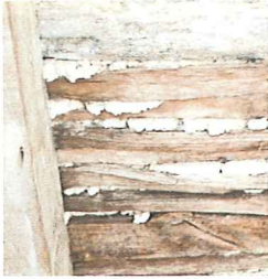
Détail de plancher en plâtre.
