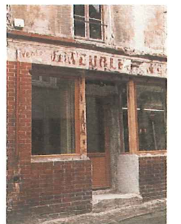
Plâtre et pigment rouge pour ce trompe-l'œil simulant la brique (stuc-brique).
