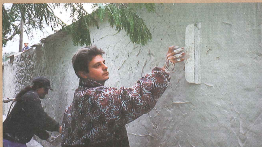
5 - Il est étalé puis strié avec un peigne métallique avant l'application de la deuxième couche.
