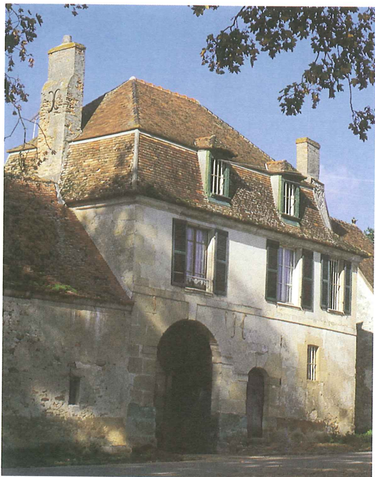
Rosoy-en-Multien (77), Revêtements en plâtre.
