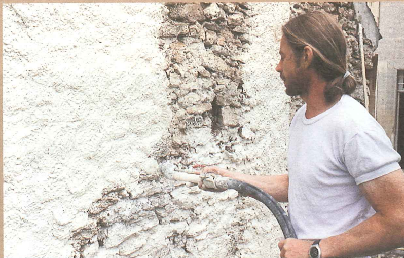
2 - La première couche est appliquée à la lance sous pression, sur la paroi à enduire.
