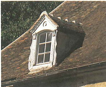
Lucarne pourvue de ruellées de plâtre.
