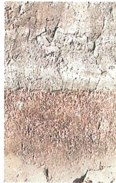
Enduit sur soubassement au mortier de tuile pilée.
