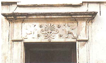
Linteaux en plâtre modelé.
