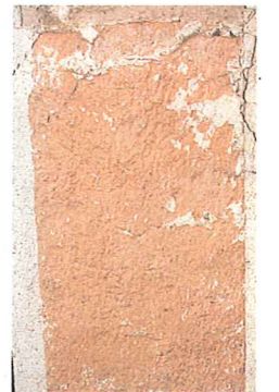
Crépi au balai en plâtre teinté rouge.
