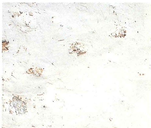
Enduit de faible épaisseur coupé au nu de la pierre.
