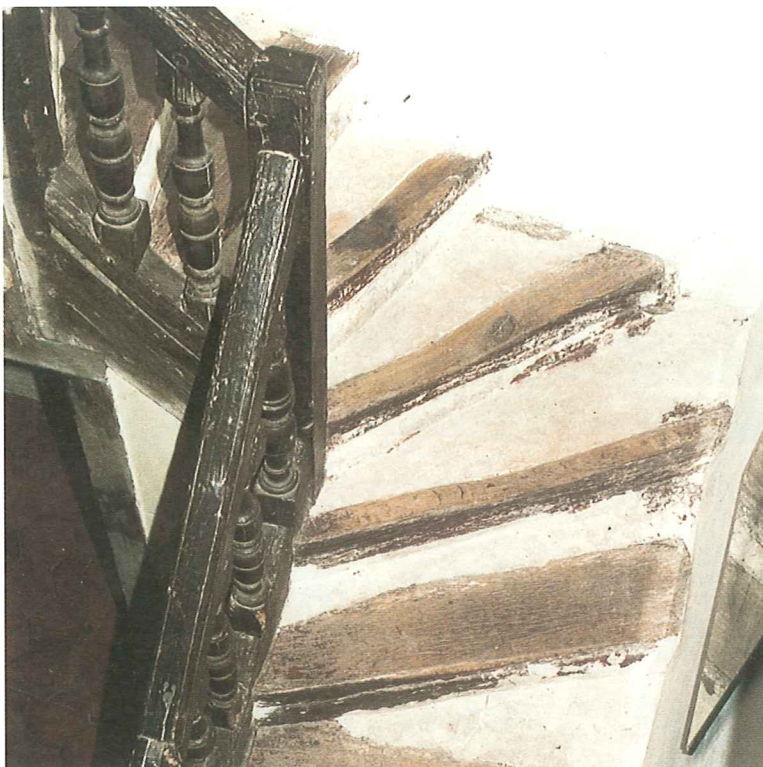
Escalier en bois du 18 e siècle avec ses marches et contre-marches en plâtre.
