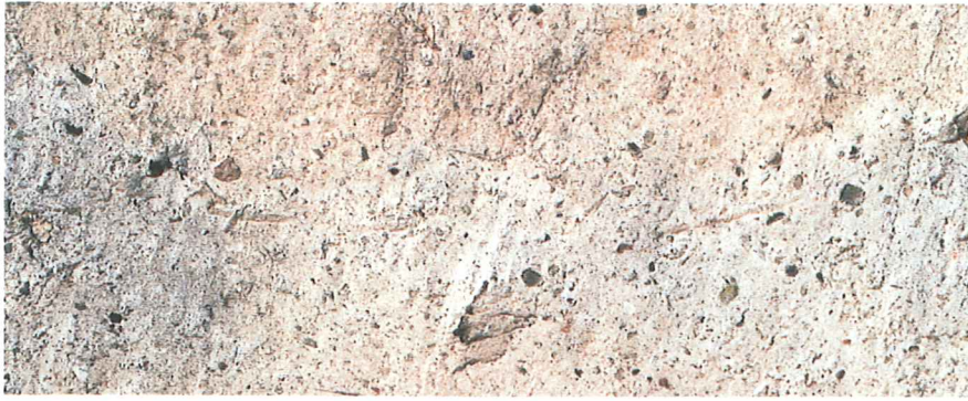
Enduit traditionnel comportant des traces de charbon de bois issus de la cuisson.
