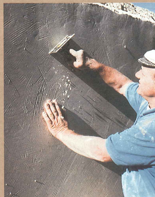
7 - Après la prise, vient enfin la finition coupée à la berthelée, d'abord avec la lame dentelée, puis avec la lame droite aiguisée.
