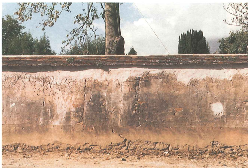
Mur appareillé en moellons calcaires dissimulés en majeure partie sous un enduit de plâtre gros.
