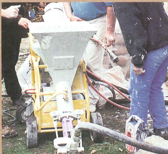
1 - Le plâtre est versé et mélangé à l'eau dans la machine à projeter.
