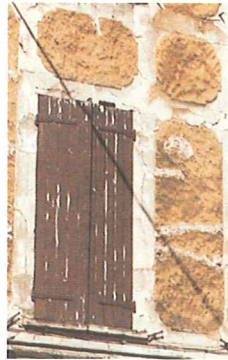
Tapisseries en crépi au balai en plâtre teinté ocre.
