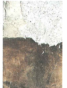
Enduit sur soubassement de mortier de tuile pilée lissée, dit ciment romain.
